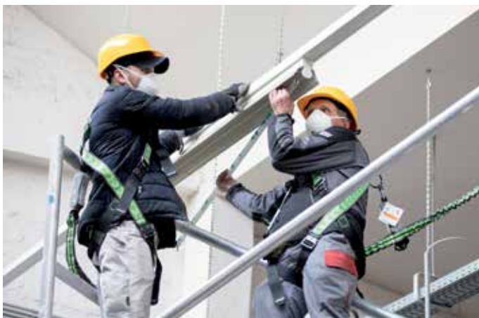
Ausbau von Leuchtstoffkörpern am Village im Dritten im Auftrag der Austrian Real Estate
