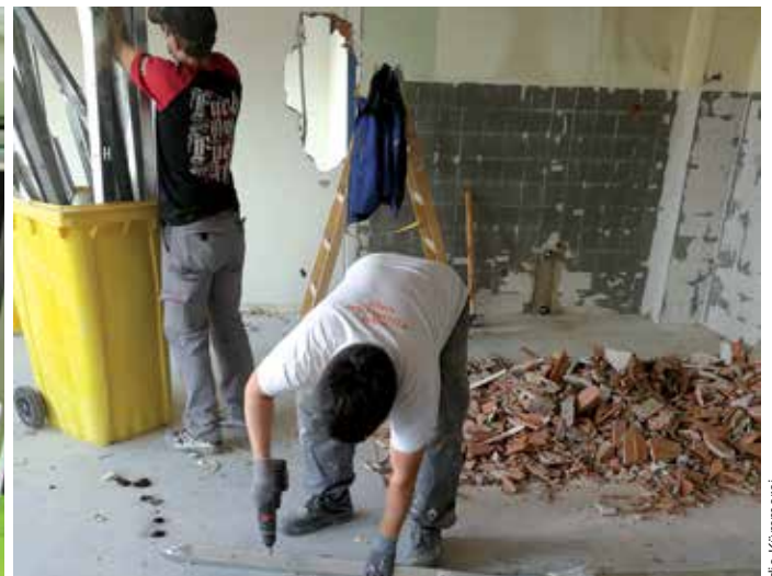
Mitarbeiter der Kümmerei trennen Altmetall aus einer Trockenbauwand
